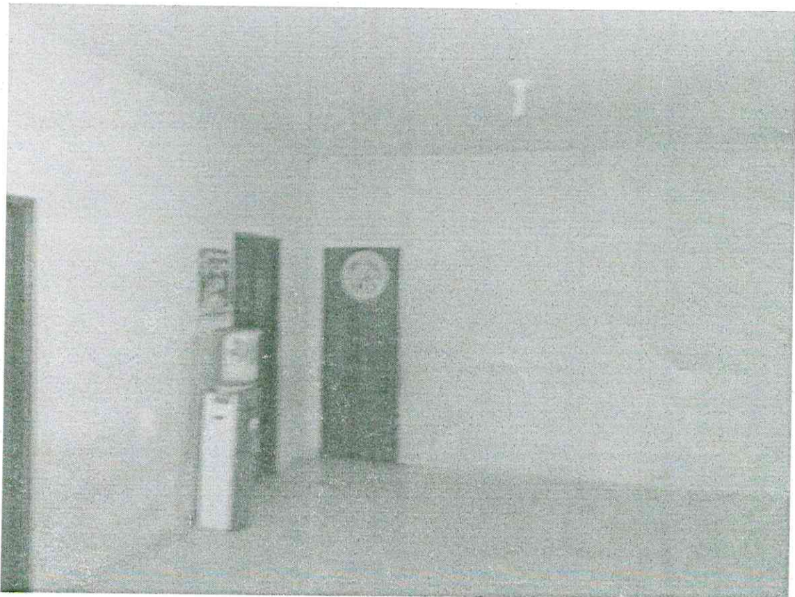
Figura 10 – Sala pavimento superior
