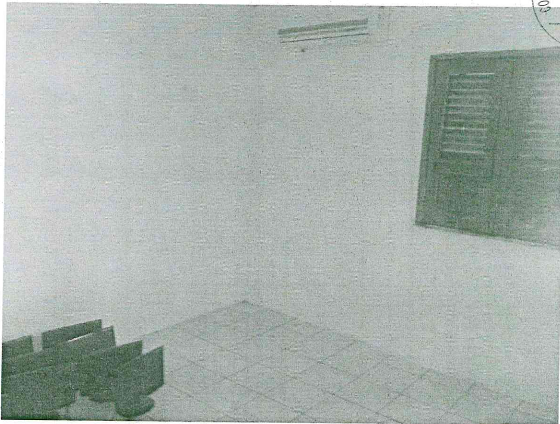
Figura 9 – Sala pavimento superior
