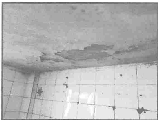
Imagem 02: Face inferior de laje
