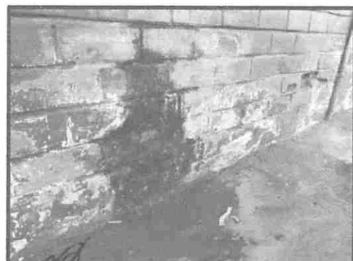
Imagem 05: Infiltração avançada
