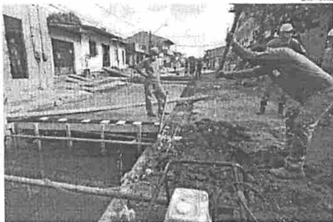
Trabalhos de revitalização da Rua da Felicidade são intensificados com a cobertura do canal de escoamento
