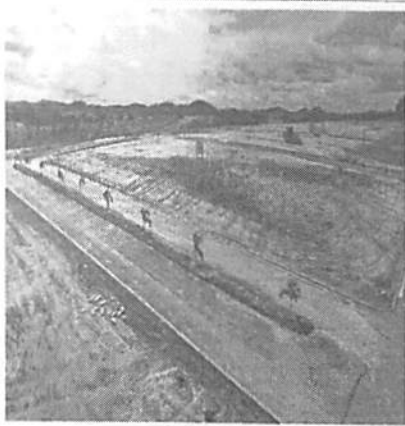
Foto 1: Canteiro Central - Avenida Principal
