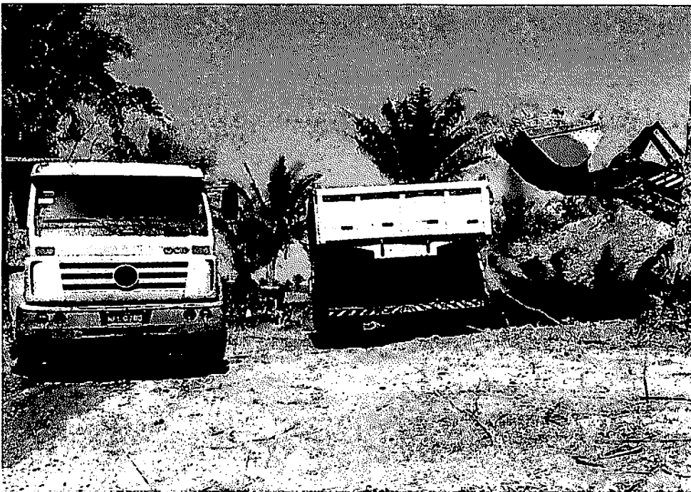
PIÇARRA DE JAZIDA PARA BASE DE PAVIMENTAÇÃO
